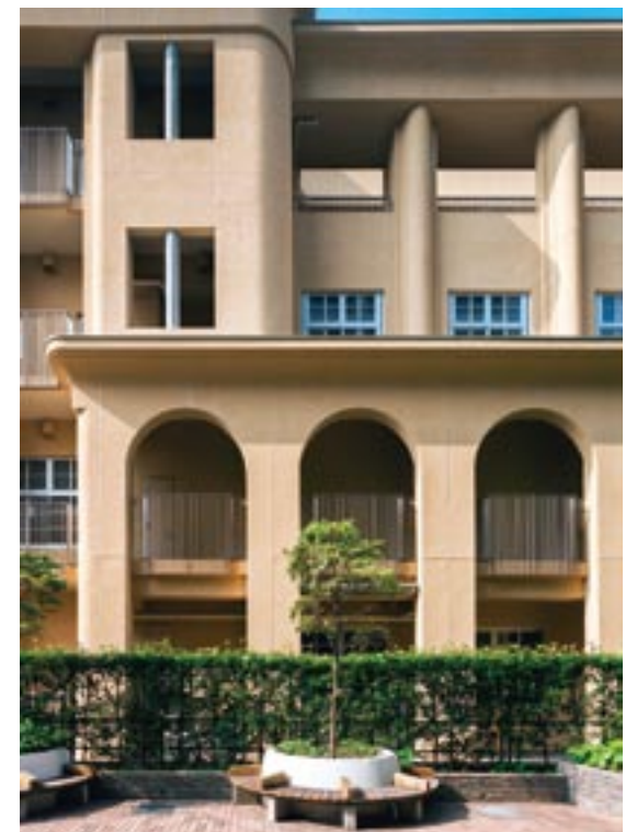
旧校舎の竣工当時の外壁色を再現
